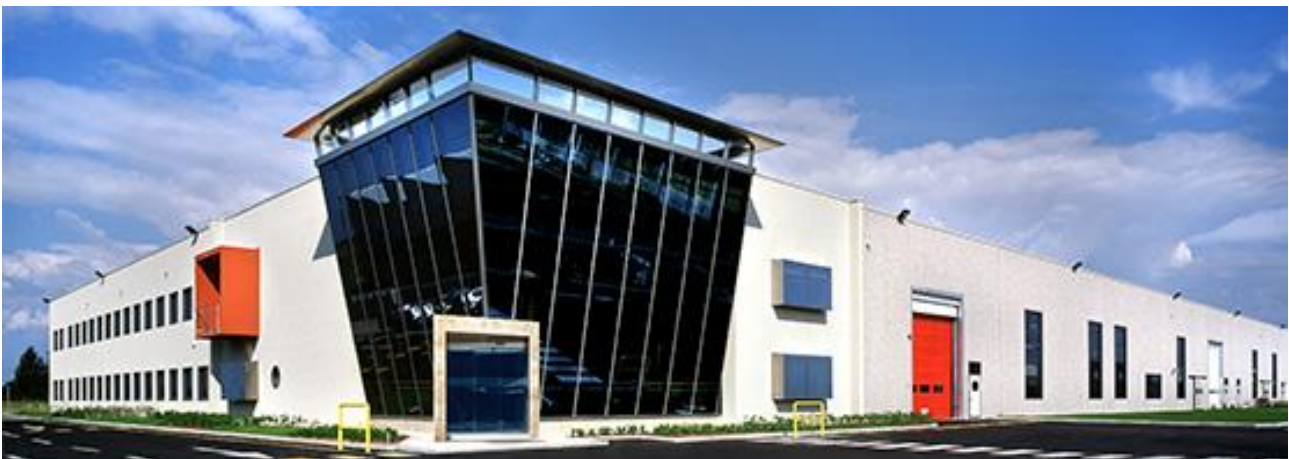
Figura 5: Vista dello stabilimento L.I.C.AR. e Unità Produttiva 2
