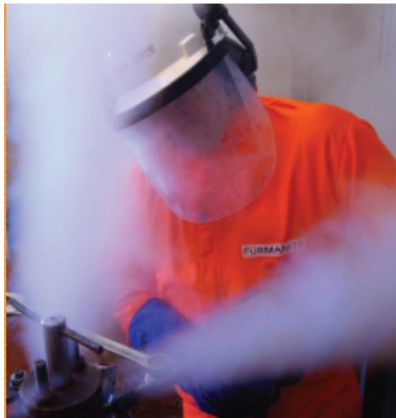
Figura 63 - Operatore in azione durante l'applicazione della scatola di furmanite [36]
