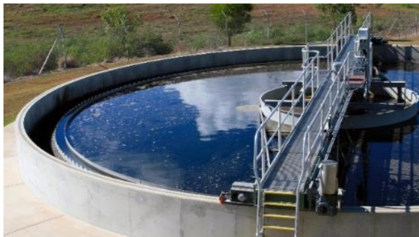
Figura 28. Vasca di depurazione delle acque
