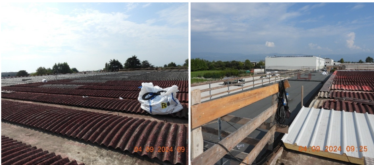
Figura 29 – Presenza dei parapetti su tutto il perimetro prospiciente al vuoto.
