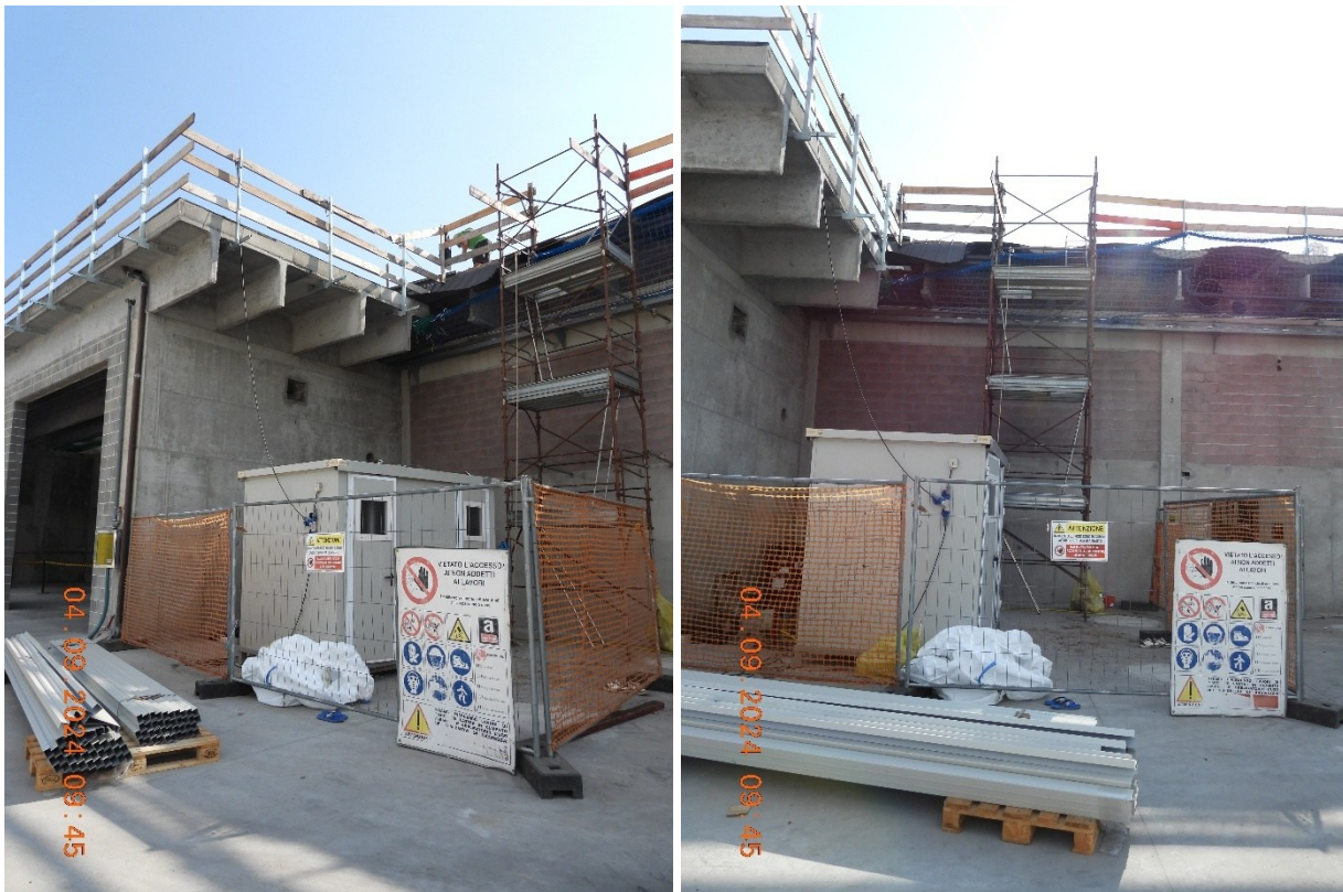
Figura 26 – Unità di decontaminazione e ponteggio di accesso alla copertura.
