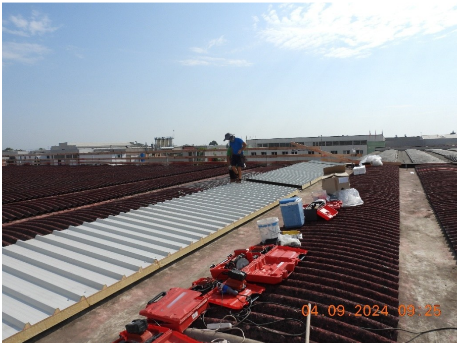
Figura 28 – Ispezione in copertura.
